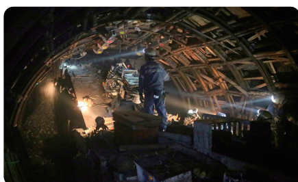
坑道内での掘削作業の様子
