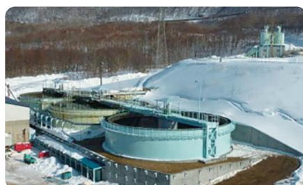
重金属を含む坑廃水の処理
