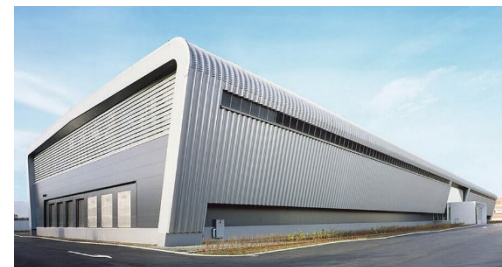
データセンター
