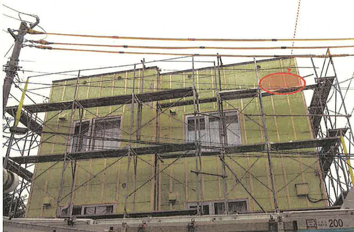
(高圧電線防護管 取付後)
