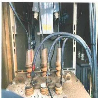
LBS下部 ヒューズの破片が散乱し、ケーブル等が焦げている ただし、各種試験の結果異常なし
