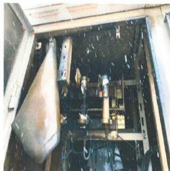
キュービクル損傷状況
