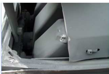
気中開閉器 アーク痕 相間隔離壁 底面より R相
