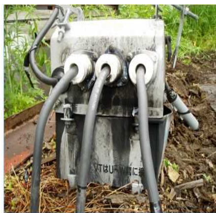
気中開閉器 戸上電機 負荷側
