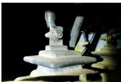
CT 電撃痕 CT負荷側
