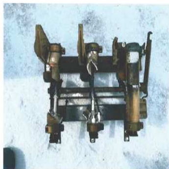
LBS損傷状況 LBS付風限流ヒューズ 左 (R相) 内部より破裂 中 (S相) 左よりの衝撃により破損 右 (T相) 左、右の発火により焼損
