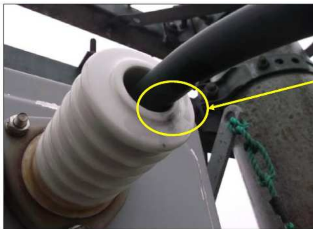
PAS1 次側ブッシングリード口出し部 アークの痕跡あり
