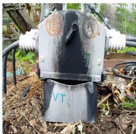
気中開閉器 戸上電機 側面 負荷側-電源側
