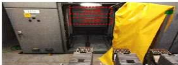
キュービクル内部
