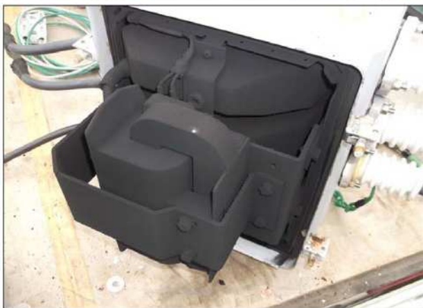
PAS内部の焼損状況
