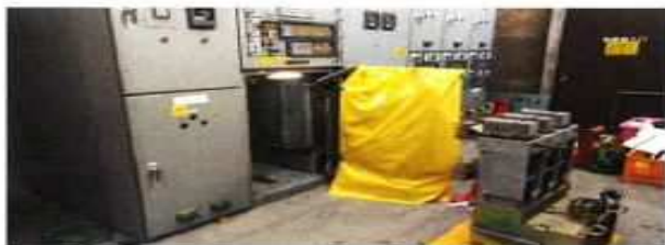
キュービクル外観
