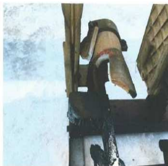
左 (R相) 通常雪や水分でのアーク放電による損傷の場合ヒューズ上下の金属部分が溶着すると思われるが、明らかにヒューズ内部よりの衝撃による破損
