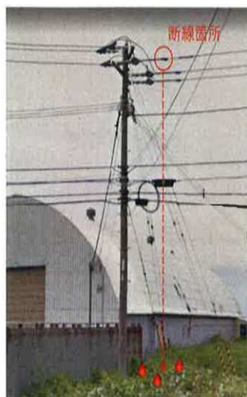
分岐スリーブカバーが滴下し、野火が発生
