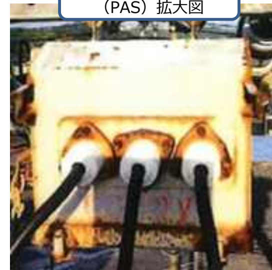
高圧気中負荷開閉器 (PAS) 拡大図
