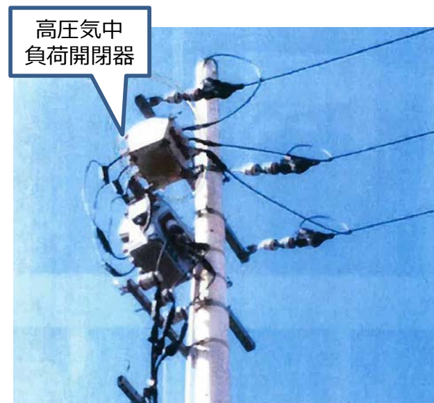
高圧気中負荷開閉器 (PAS) 拡大図
