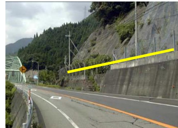
山地の道路沿いの擁壁上部
