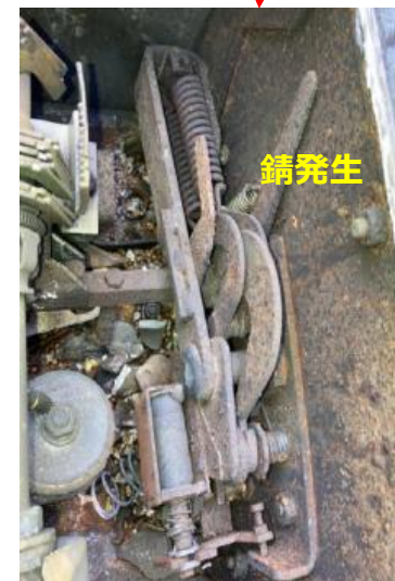
②壁・操作ハンドル機構部の破損状態
