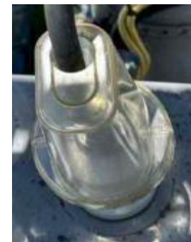
屋外用（隙間なし）に 取替
