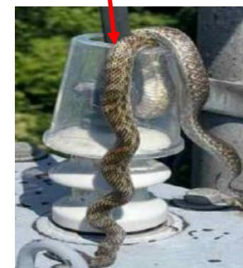
ヘビがブッシングカバーの隙間から侵入し端子部に接触
