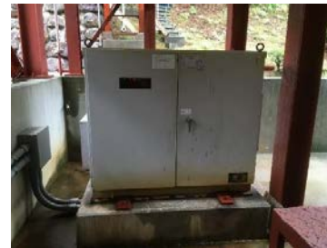
3台確認 非常用発電機
