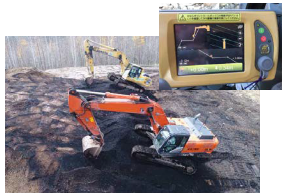
（ICT建機による施工）
