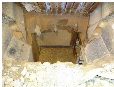
罹災者が作業していたシュート足場
