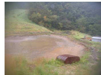
非常用沈殿池
