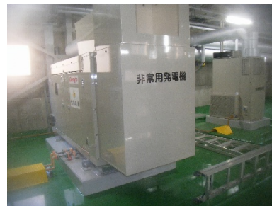
新設 非常用発電機
