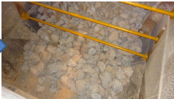
シュート足場に安全柵を設置
