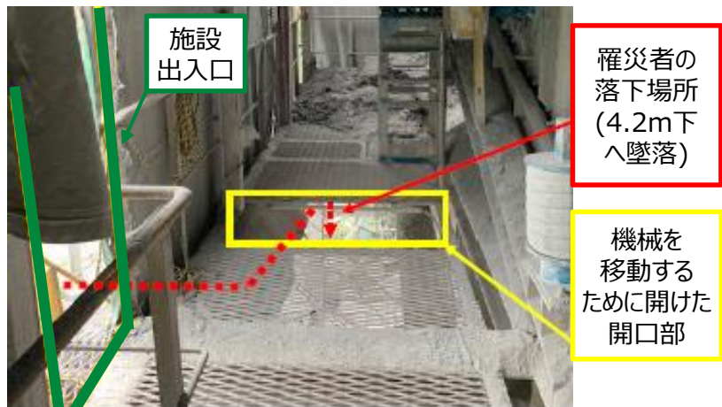
開口部からの墜落（令和2年8月）
