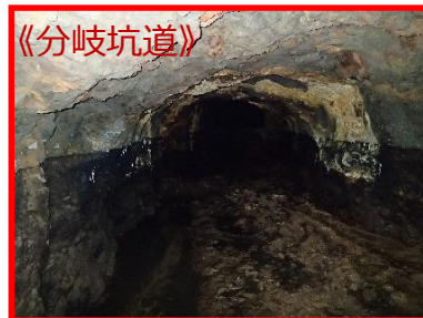
③分岐坑道（一部埋め戻しを実施）
