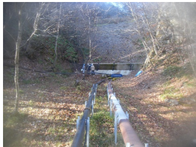
廃水（浸透水） 集水・導水
