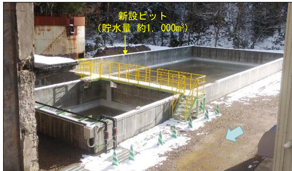
貯水槽全景 (完成後)
