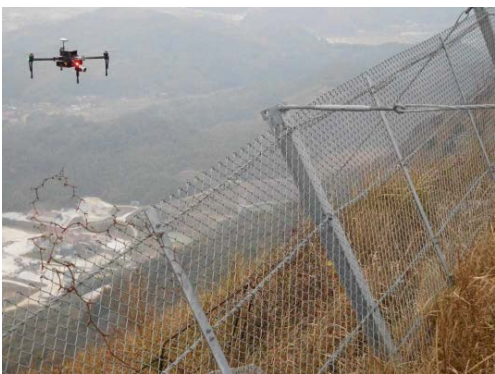
(斜面地の落石防止柵点検)
