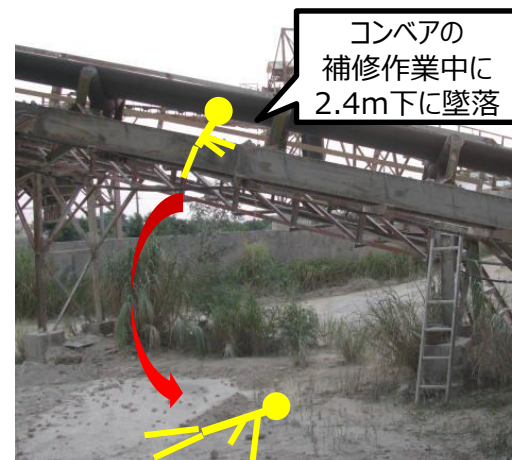
設備からの墜落（令和2年10月） 8
