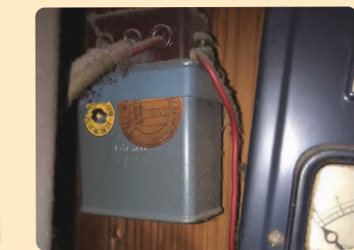
配電盤に設置された 低圧コンデンサー
