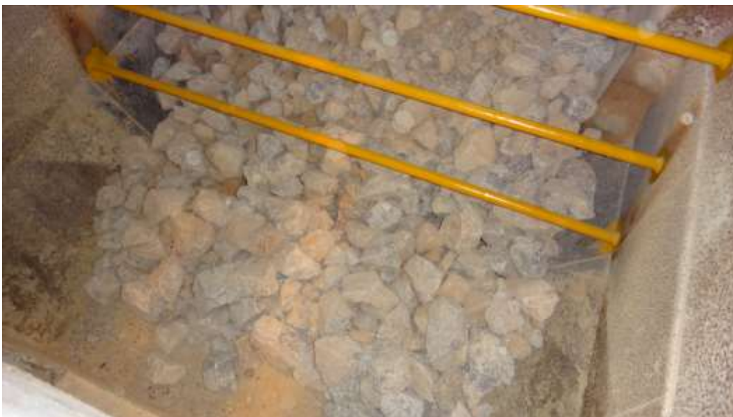
シュート足場に安全柵を設置
