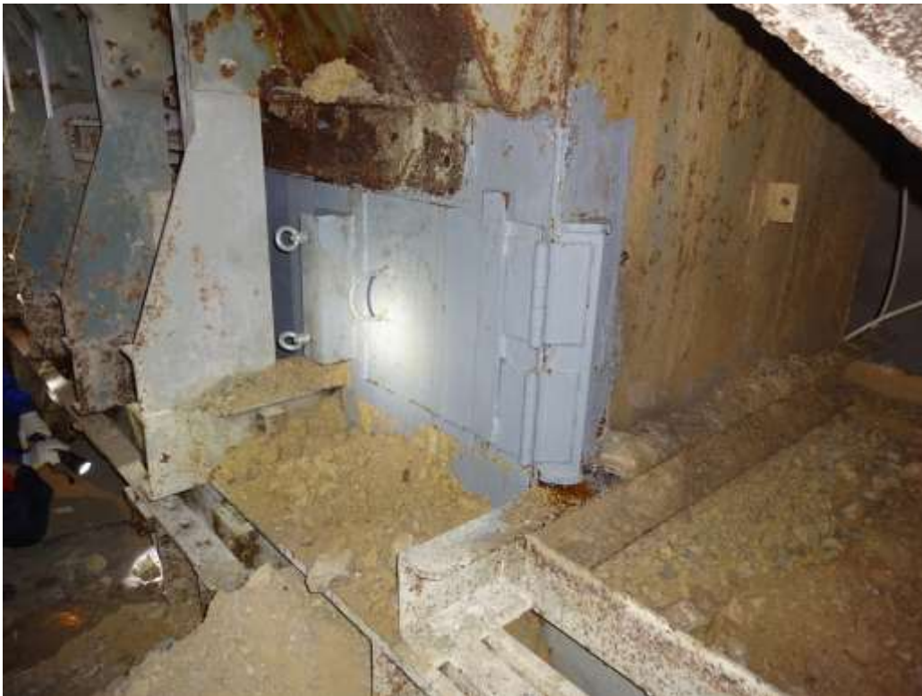
新たにシュート側部に設置した開口部
