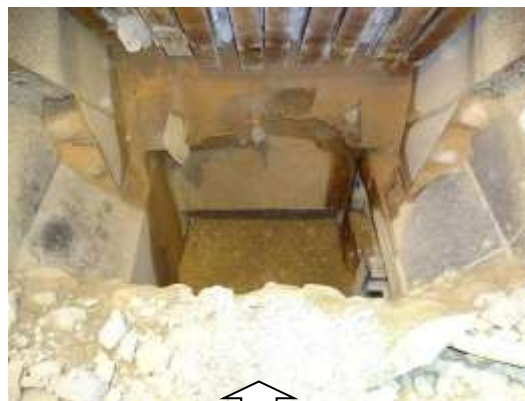
罹災者が作業していた足場とシュート (①の開口部の内部)
