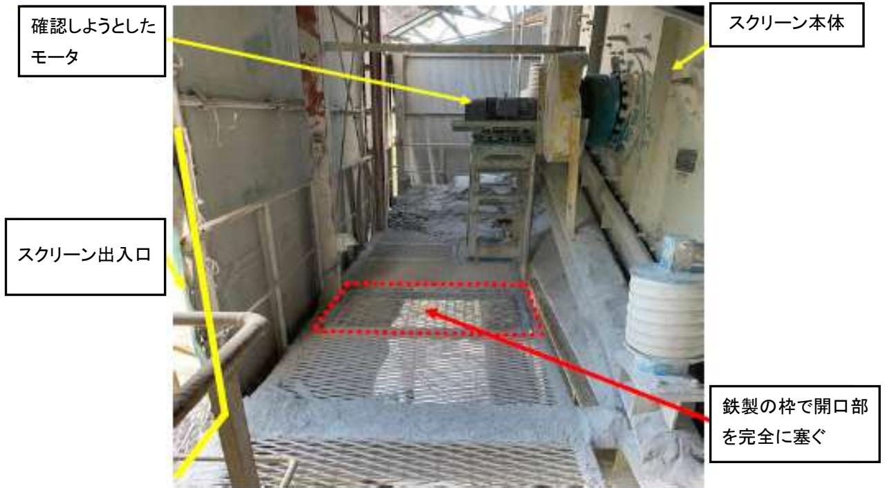
写真4 災害現場恒久処置
