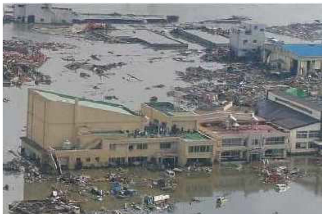
津波による被害
