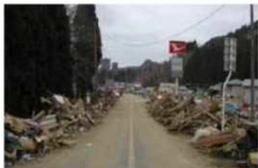
道路の啓開によるルートの確保
