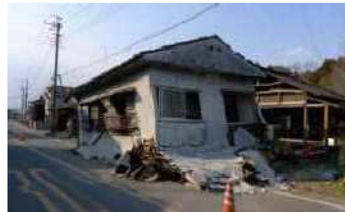
揺れによる被害
