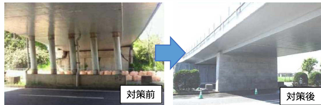
橋梁の耐震化の事例
