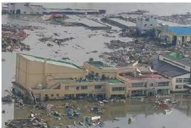
津波による被害
