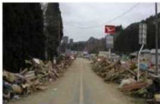
道路の啓開によるルートの確保
