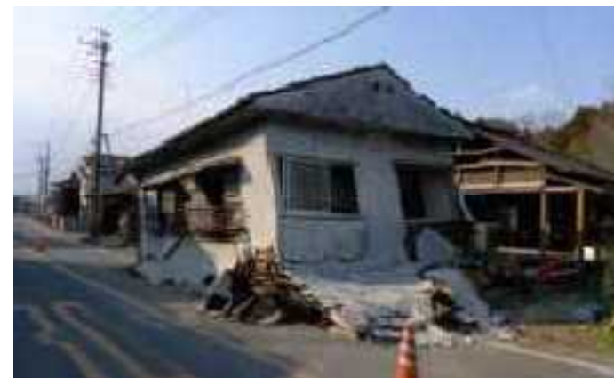
揺れによる被害
