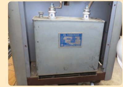
低圧分電盤内の 低圧コンデンサー
