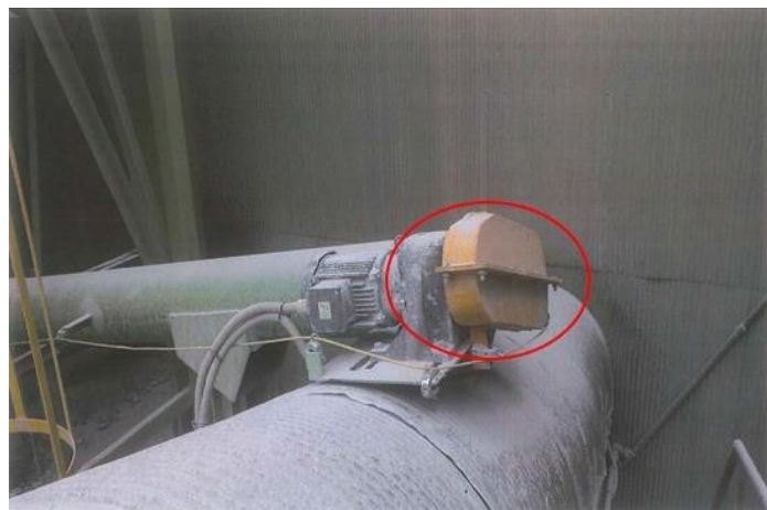
原動機チェーン駆動部カバー
