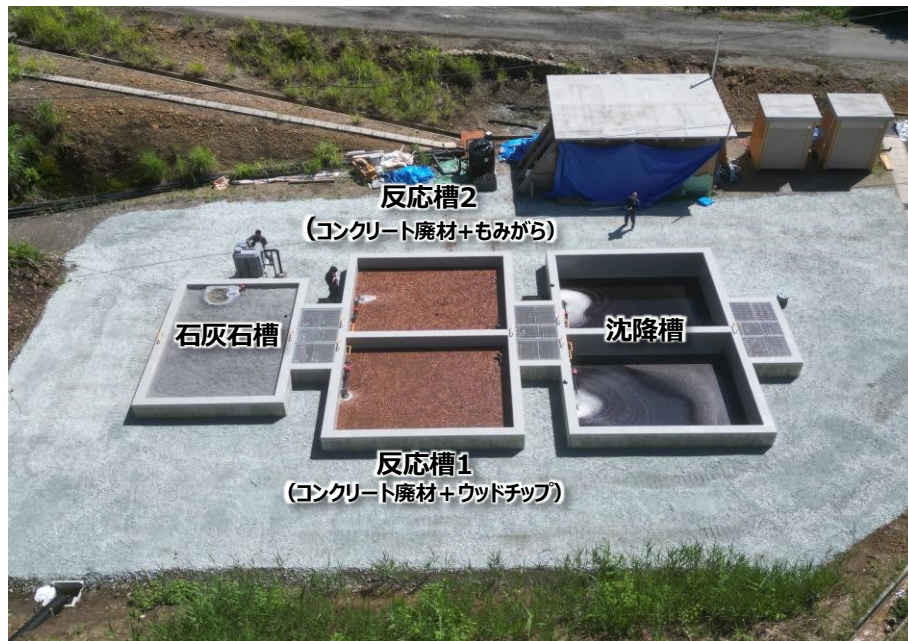
コンクリート廃材+もみがら等を活用したパッシブトリートメント
