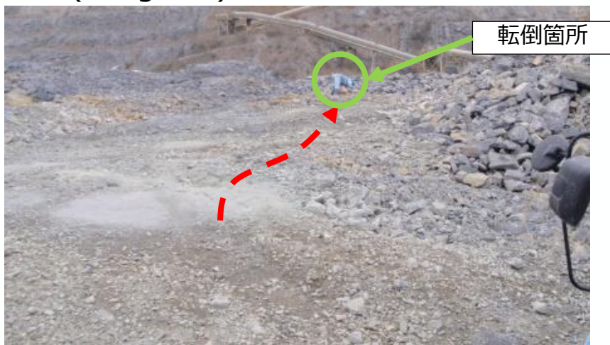
罹災箇所遠景（赤破線は運搬経路）
