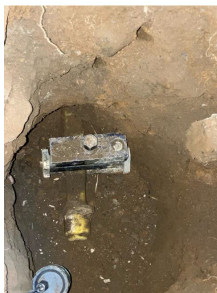
地境切断掘削口 地境切断箇所
