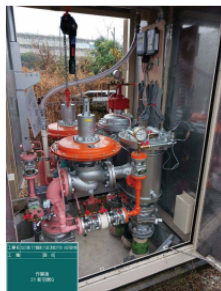
▲新羽黒ガバナ-自記圧力計DA307N取付け(右)
