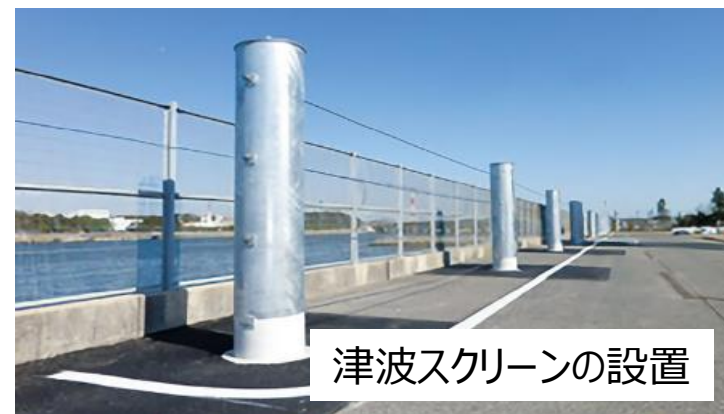
防潮堤の設置
