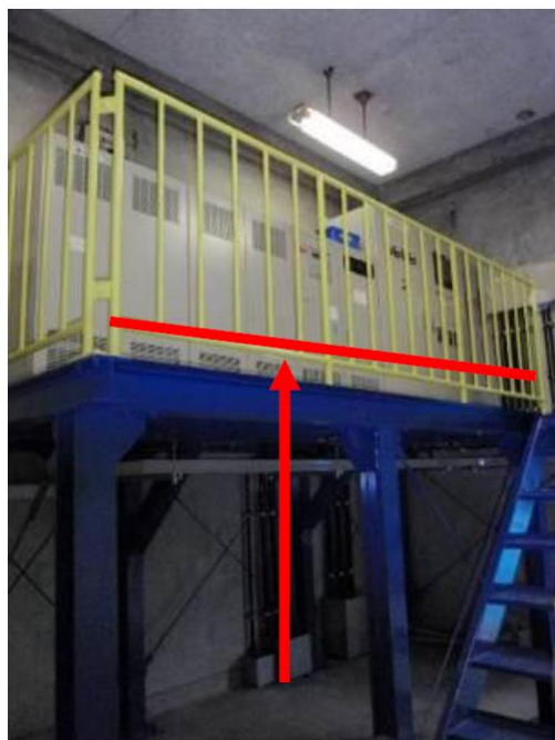
電気設備の嵩上げ
