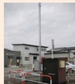
▲子局ガバナ、銅管柱及び遠隔監視制御盤
